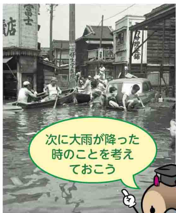
昭和33年7月23日 台風第11号被害状況(城東地区) 浅間小学校付近の浸水状況
