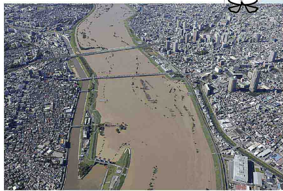
令和元年台風第19号通過後の荒川様子（上区、観測所付近 10月13日13時頃 約A.P.+7.01m（氾濫危険水位よりも約70cm低い状況））
