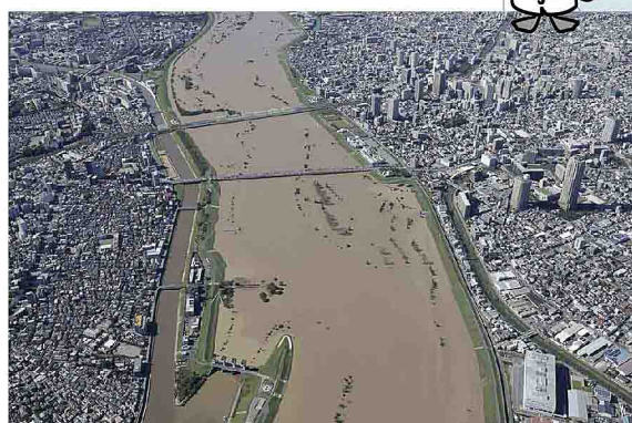
令和元年台風19号通過後の荒川様子 (上区、葛西橋付近 10月13日13時頃 約A.P.+7.01m (氾濫危険水位よりも約70cm低い状況))
