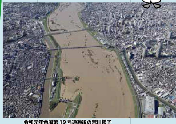
令和元年台風第19号通過後の荒川(北区、岩淵水門付近 10月13日13時頃 約A.P.+7.01m(氾濫危険水位よりも約70cm低い状況))
