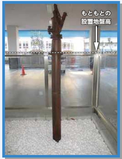
左：満潮時、護岸の最上部近くまで水が迫る小名木川。左側はかさ上げた新護岸。昭和45年9月30日 右：昭和13年に掘り抜いた井戸。地盤沈下の影響により、もともとの設置地盤面より現在の地盤面が低くなっています。(葛飾区東新小岩1丁目) 提供：東京都第五建設事務所
