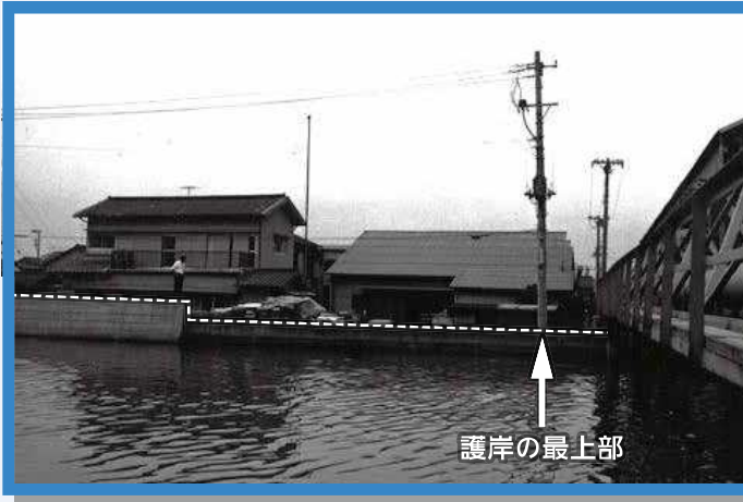
左：満潮時、護岸の最上部近くまで水が迫る小名木川。左側はかさ上げた新護岸。昭和45年9月30日 右：昭和13年に掘り抜いた井戸。地盤沈下の影響により、もともとの設置地盤面より現在の地盤面が低くなっています。(葛飾区東新小岩1丁目) 提供：東京都第五建設事務所
