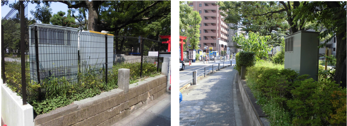
公園等の公共用地を活用して地上機器を設置した例
