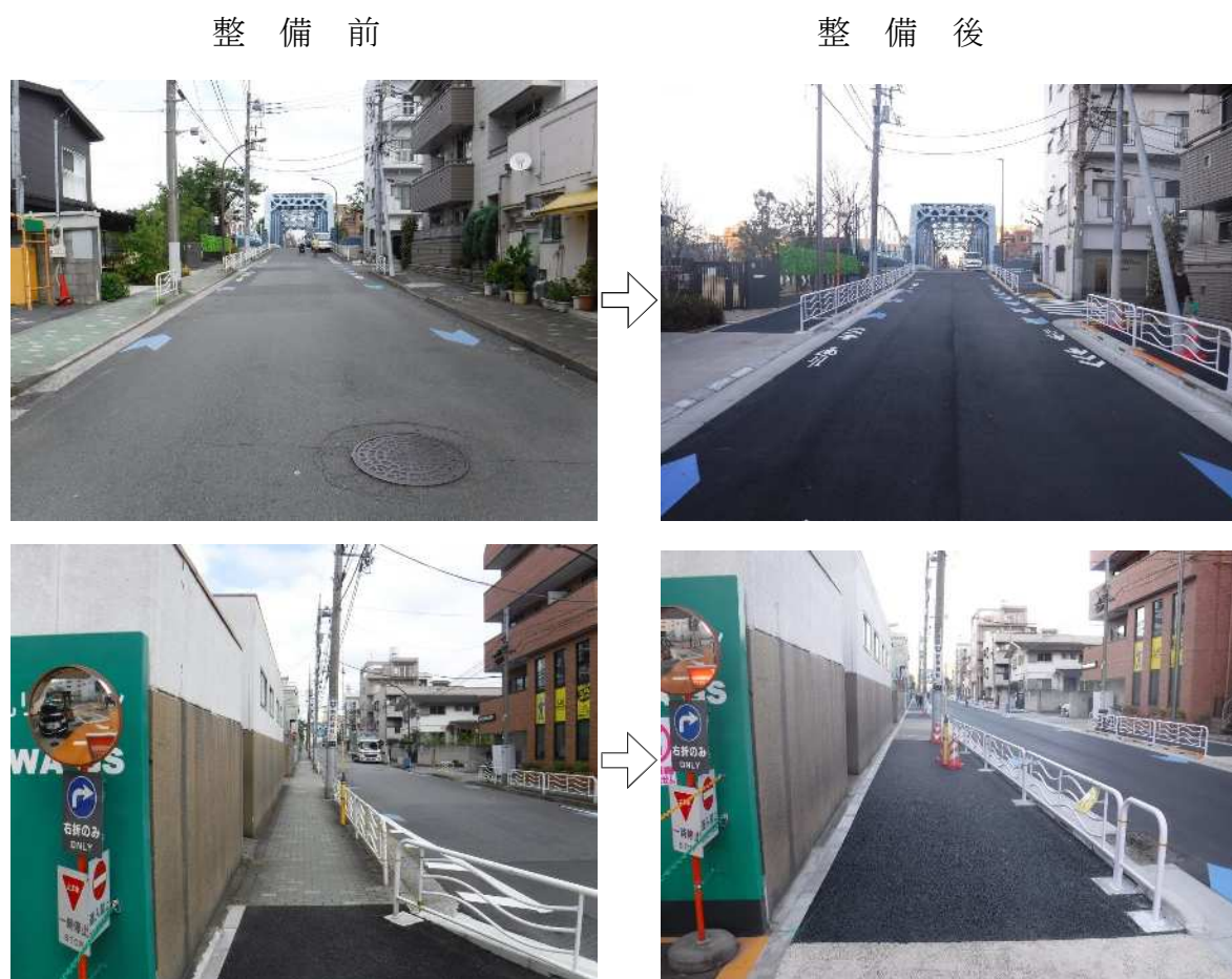
図－13 歩道拡幅整備の状況
