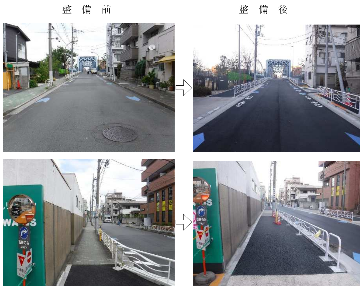
図－13 歩道拡幅整備の状況
