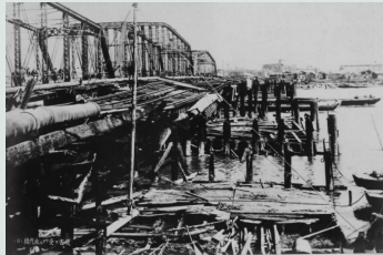
被災した永代橋と焼け落ちた電車仮橋
