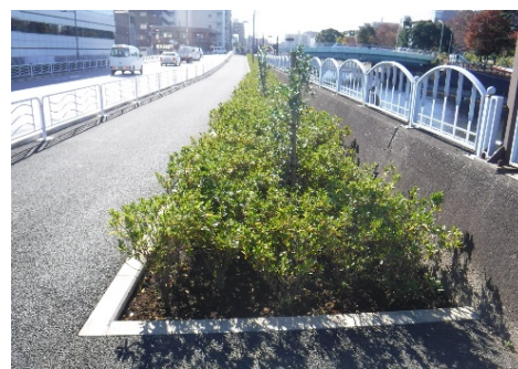
図 6.2.2 新設された植樹帯
