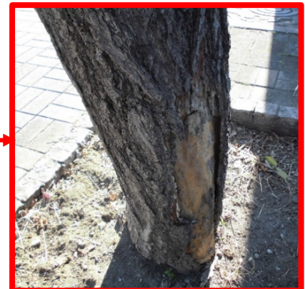
写真 4.5.4 根元の開口空洞状況
