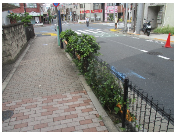
写真 4.3.6 ヘデラによる隙間緑化
