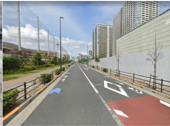
写真 2.3.5 街路樹の生育不全の状況
