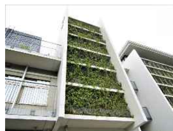
壁面緑化 (豊洲西小学校)
