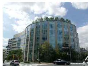
優良緑化事例 (江東リハビリテーション病院)
