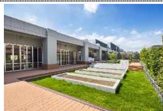
屋上緑化（第二大島中学校）
