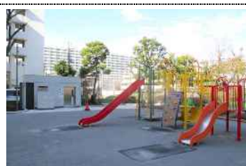
公園改修（大島四丁目第二）
