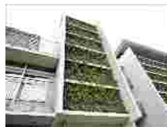
壁面緑化 (豊洲西小学校)
