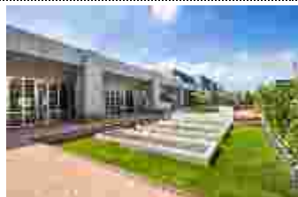
屋上緑化（第二大島中学校）
