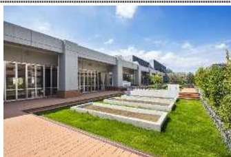
屋上緑化（第二大島中学校）
