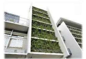
壁面緑化による 室温低下
