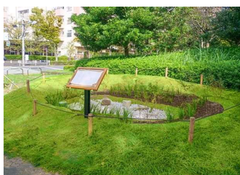
写真 4-14 雨庭（雨水貯留浸透）
