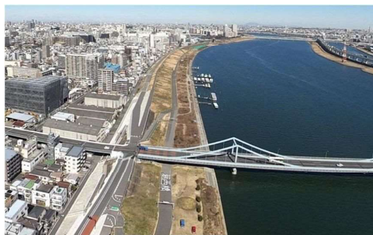
写真 4-3 荒川 【出典】荒川知水資料館 amoa ウェブサイト 「荒川 River-SKY-View」
