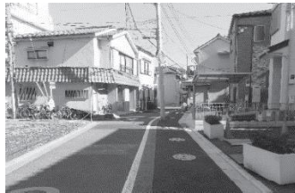
道路拡幅整備（6m） （荒川二・四・七丁目）
