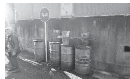
消火用水と防災バケツ
