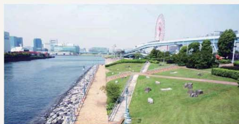
環境に配慮した護岸
