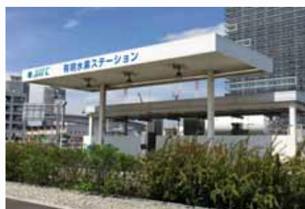
水素ステーション
