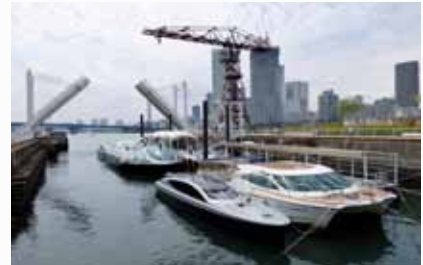
棧橋・係留施設
