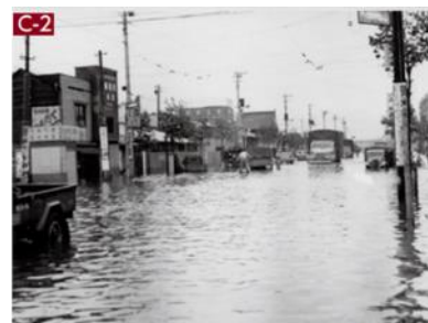
新大橋通り(大島3丁目付近)
