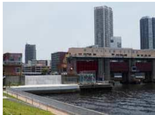
江東区の水害を守っている「東雲水門」
