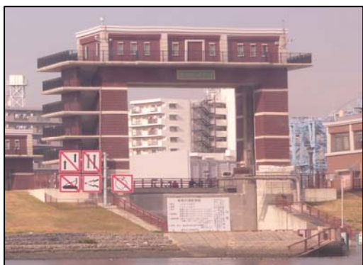
【荒川ロックゲート】
