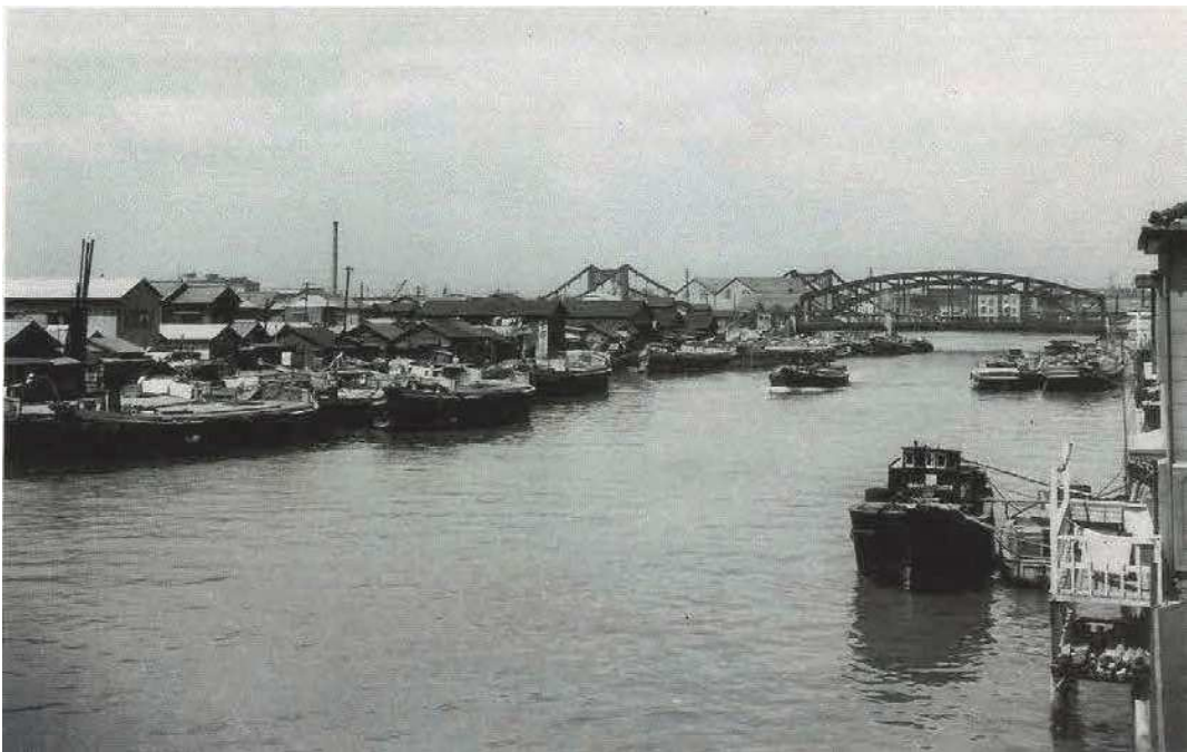
高橋から万年橋、清洲橋をのぞむ（昭和30年）
