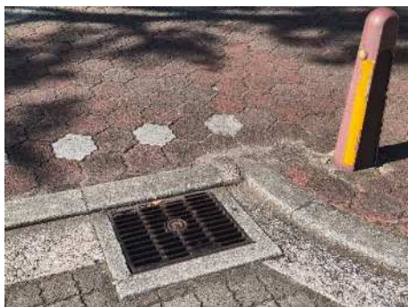
コミュニティ道路（区役所前）：側溝のふた
