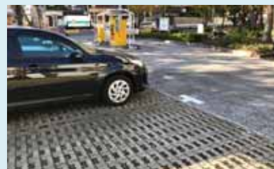
透水性舗装：緑化ブロックで 雨水を地中に分散・浸透 （江東区役所駐車場）
