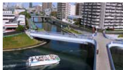
小名木川クローバー橋
