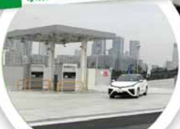
水素ステーション
