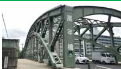
万年橋（都市景観重要建造物）
