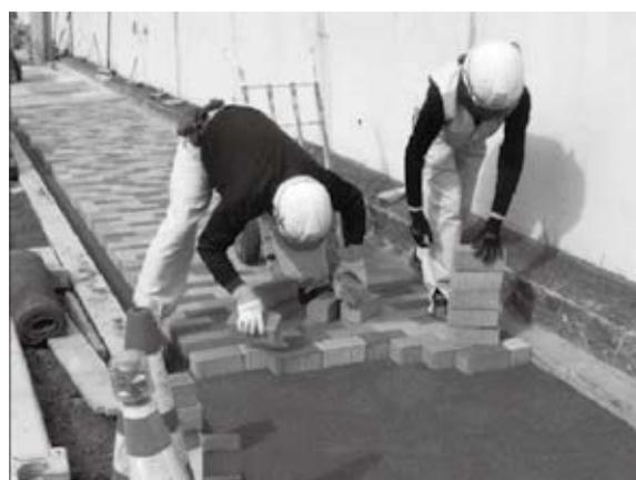
透水性舗装工事（インターロッキングブロック）の様子
