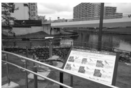
公園側からも発電機が見られる
