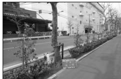
街路樹充実工事後
