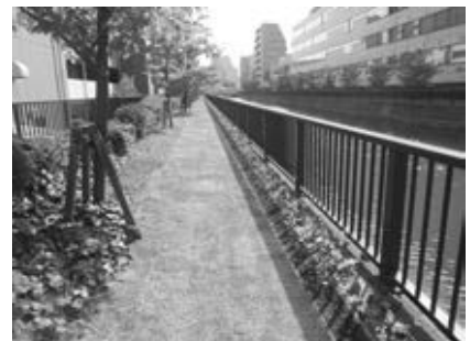
大横川（平成 29 年度施工）
