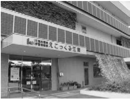
環境学習情報館設置 太陽光パネル
