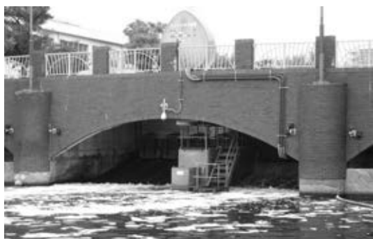
橋の下の発電機
