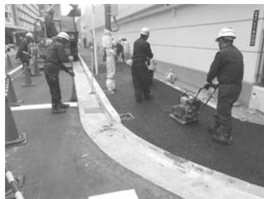
透水性舗装工事の様子
