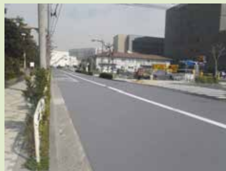
遮熱性舗装が施された道路
