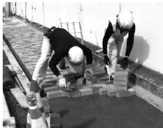
透水性舗装工事(インターロッキングブロック)の様子
