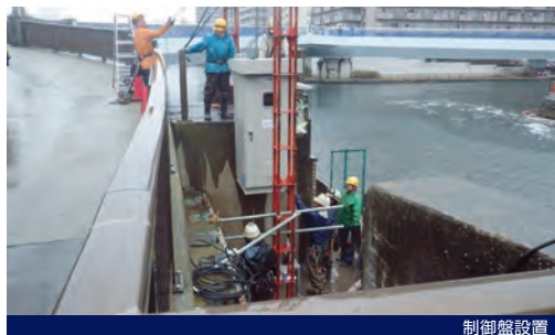
制御盤設置
