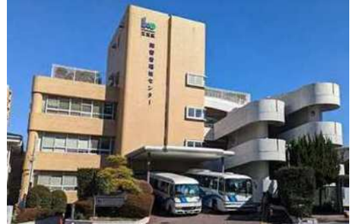
<障害者福祉センター外観>
