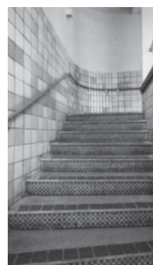
竣工当時の姿を残している1階と2階をつなぐ階段室部分
