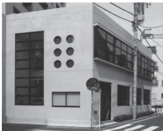
装飾のない水平に連続するスチールサッシの窓が特徴の外観
