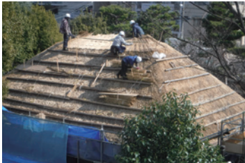
葺き替えの様子(平成29年2月)
