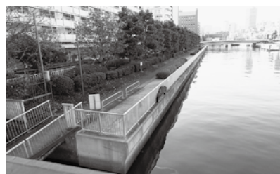
図4 小名木川南岸(西深川橋上より高橋方向)
