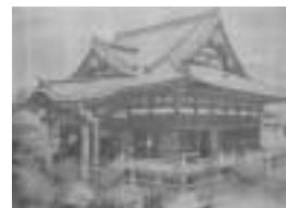
移築直後の深川不動堂本堂
