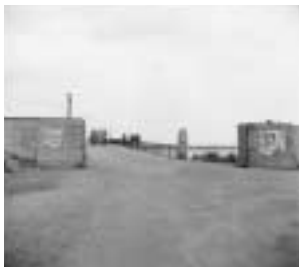
旧葛西橋西詰正面 (昭和30年ころ)
