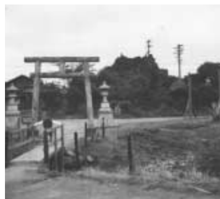
周囲に高い建物がなく、目立っていました(昭和30年頃)
