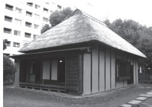
旧大石家住宅 〈区指定有形文化財（建造物）〉
