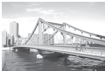
清洲橋 〈国重要文化財（建造物）〉
