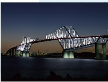
©東京港湾局 東京ゲートブリッジ
