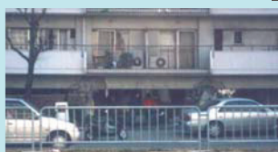
ピロティが潰れたマンション （阪神・淡路大震災）
