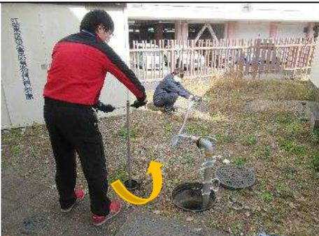
お互いに合図を取りつつ仕切弁を開けます。仕切弁を開ける際には、開栓器をゆっくり回し、反時計回り5センチ程度回したら一度止めます。
