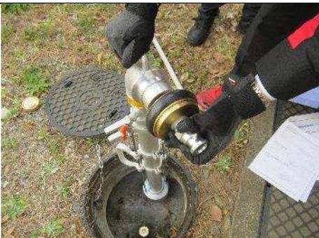
スタンドパイプに接続金具をセットします。カチッと音がすれば接続されております。
