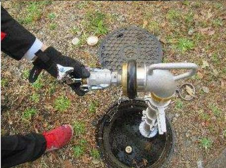
蛇口アダプターのプルリングを引いて固定します。固定後に引っ張って蛇口アダプターが抜けないことを確認します。
