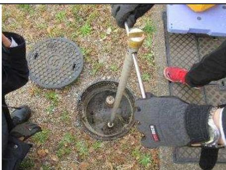
①マンホール(鉄蓋)を開けて、急な出水がないように給水弁が締まっているかを確認します。
