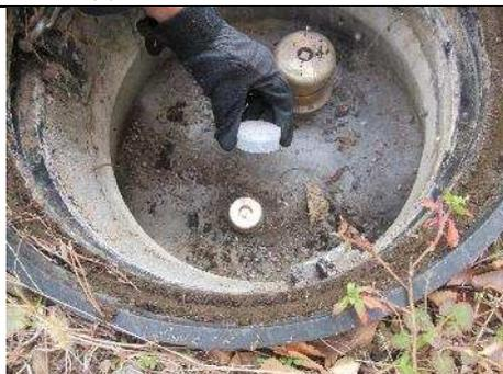
給水弁のキャップを外す。外したキャップは紛失しないよう機材が入っていたバックに入れて保管します。
