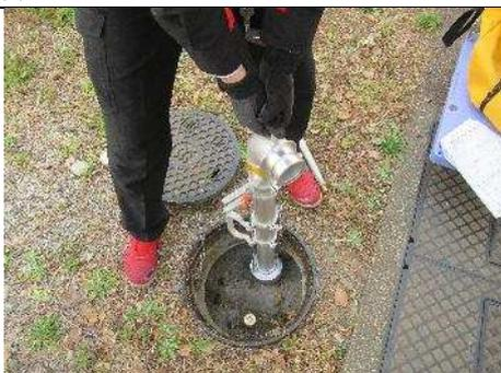
給水栓放水口にスタンドパイプを真上から押し込み設置します。
