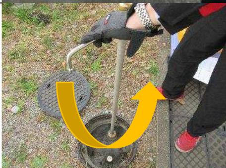
開栓器を鍵穴にセットし、反時計回りに3回転ほど回します。
