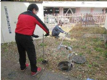
②スタンドパイプを給水栓にセットし、接続金具およびホースをセットします。仕切弁を開栓して、給水管に付着した汚れなどを落とすため、排水作業を行います。
