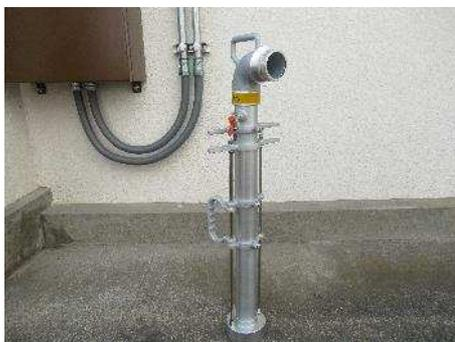
排水作業および給水作業時に使用します。給水栓の口に設置します。
