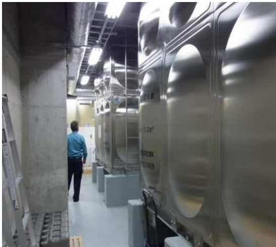
地下1階受水槽室内
