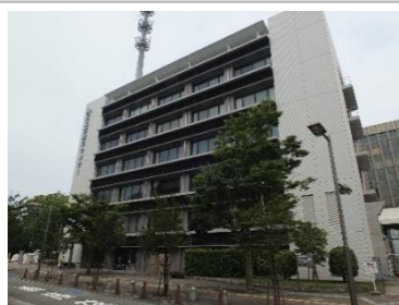
■防災センター
