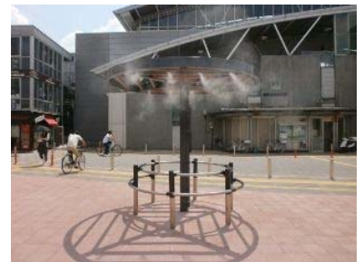
整備例(京王線 飛田給駅前)
