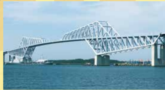
東京ゲートブリッジ
