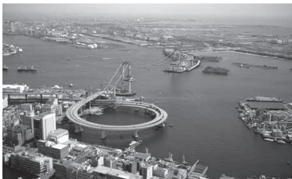
平成3年度 建設中のレインボーブリック ジと臨海部
