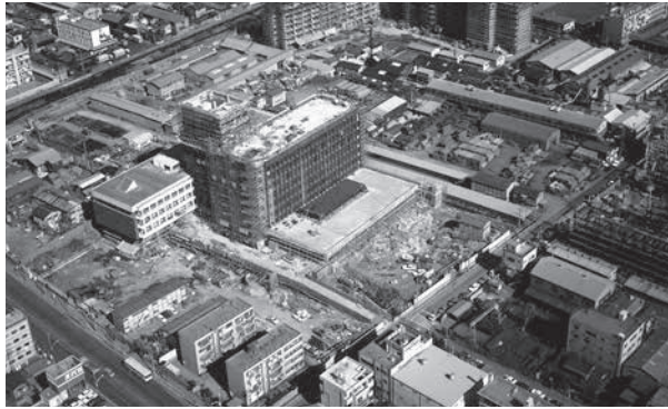
昭和48年度 新庁舎（現在の区役所本 庁舎）工事
