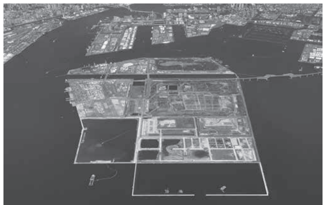
埋立てが進む臨海部（令和7年）
