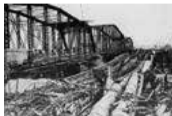
▲鉄骨を残して焼失した永代橋 (国立国会図書館 デジタルコレクションより)
