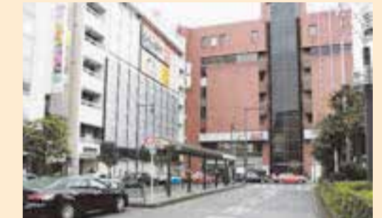
▲亀戸駅前ロータリー
